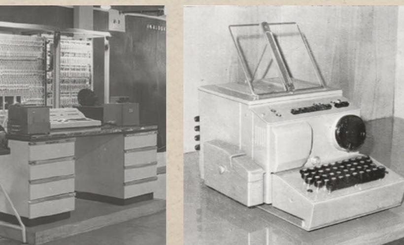
Elektronski Računar)-10, računar zasnovan na elektronskim cevima, tranzistorima i elektronskim relejima. Trošio je 60 kW električne energije i mogao je da ostvari 50,000 jednostavnih operacija u sekundi.
